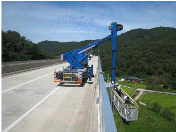
굴절점검차를 이용한 근접조사
