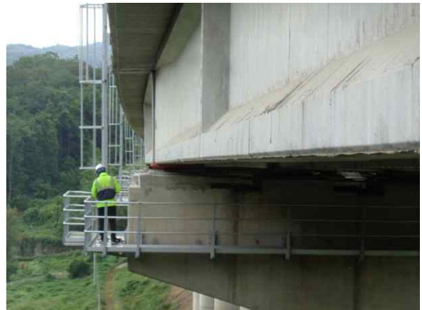
도보를 이용한 근접조사
